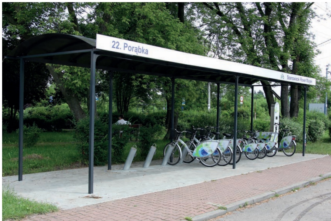
Budowa stacji rowerów miejskich w Porąbce ul. Zagórska / Wiejska.
