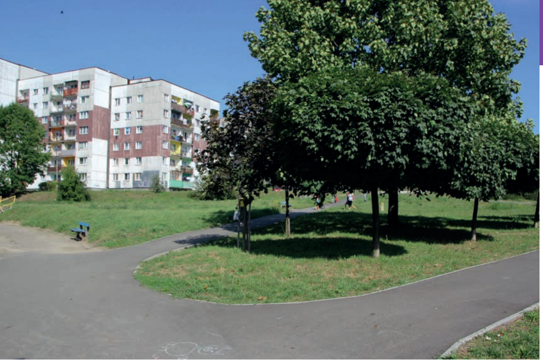
Rewitalizacja chodników na osiedlu Śródula – Plac Braci Kozuchów.
