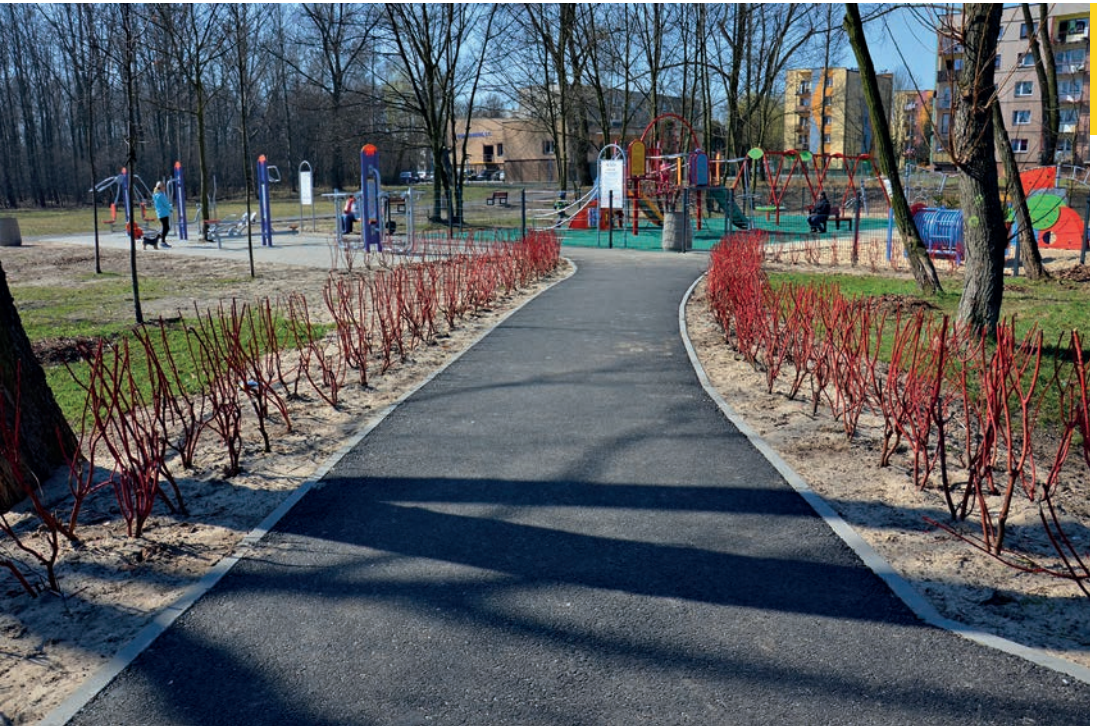
Remont chodnika i montaż progów zwalniających, ul. Biała Przemsza.
