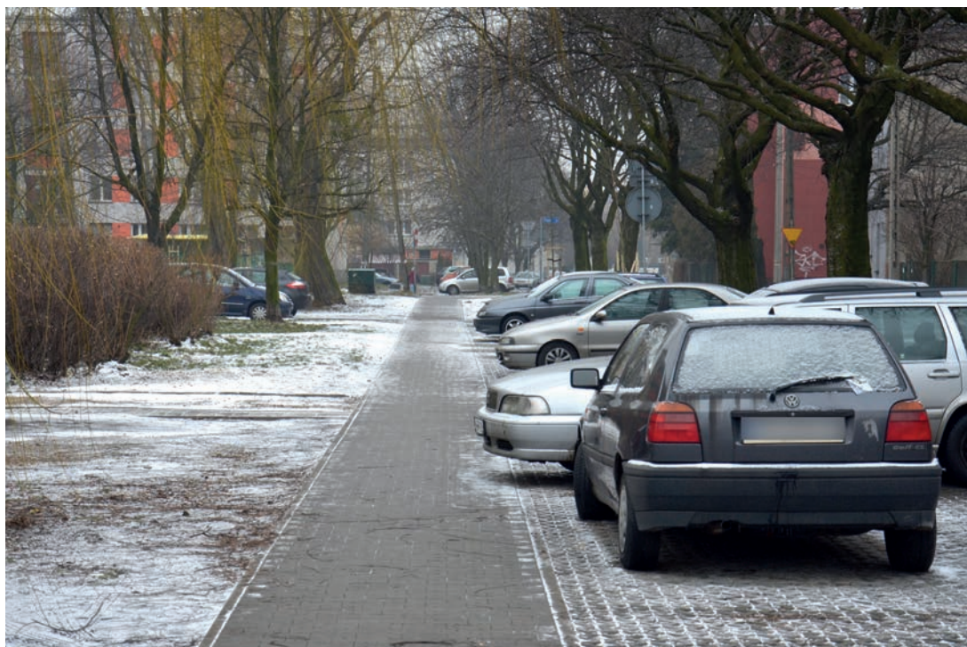
Remont chodnika i budowa parkingu przy SP nr 10, ul. Reymonta.
