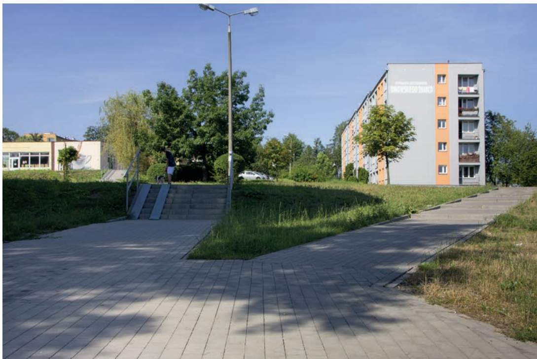
Remont schodów, chodników, budowa parkingu i nasadzenie drzew przy ul. Dmowskiego / Wiosny Ludów.
