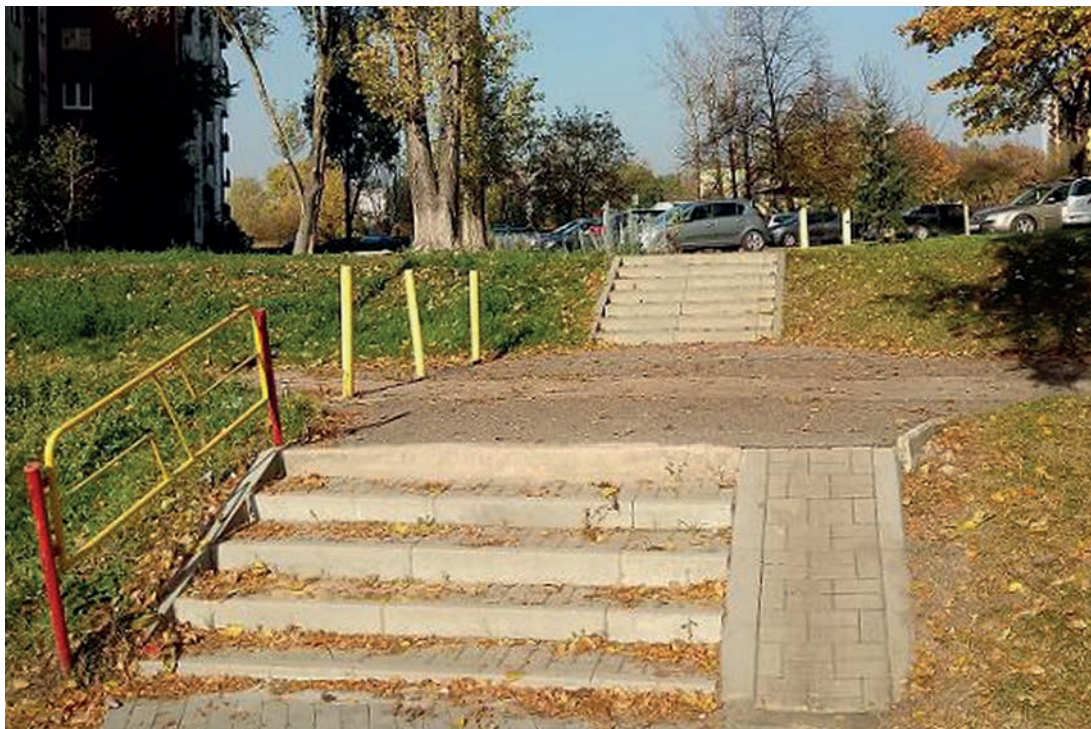
Remont schodów na ul. BMC.
