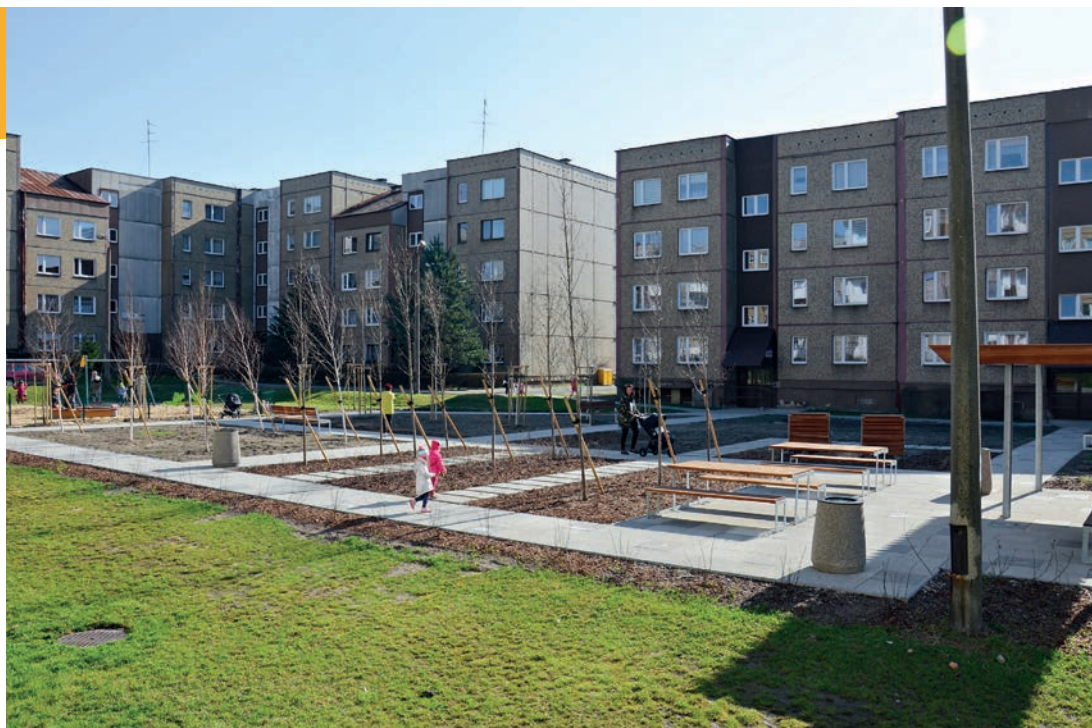
Budowa skweru, ul. Sikorskiego.
