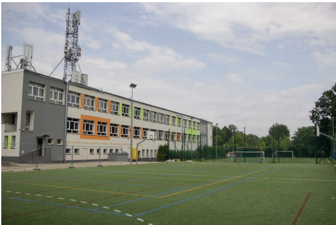
Boiska wielofunkcyjne przy ZSO nr 12, ul. Jasieńskiego.
