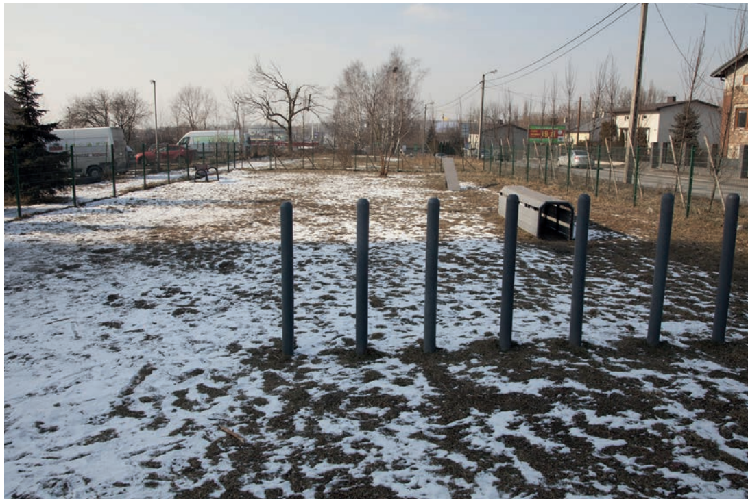
Budowa i rozbudowa wybiegu dla psów, ul. Długosza.
