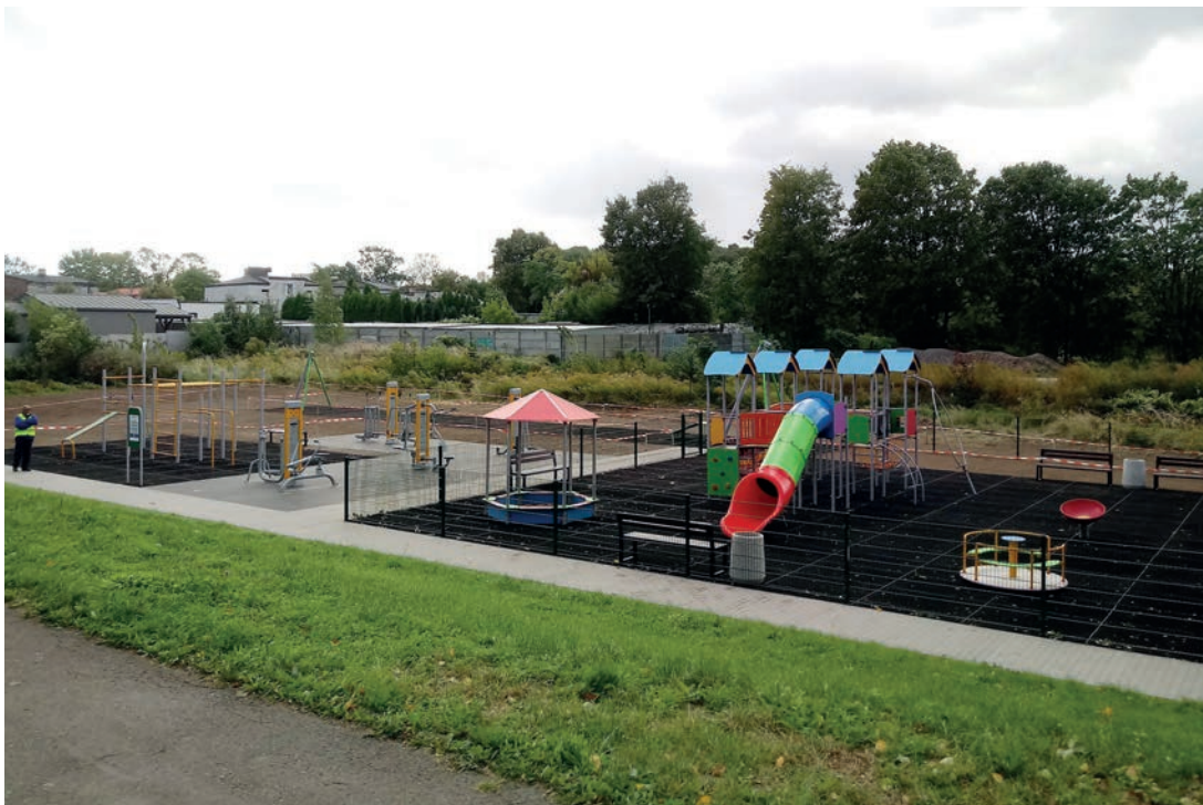
Modernizacja placu zabaw, budowa siłowni i street workoutu, ul. Długosza.
