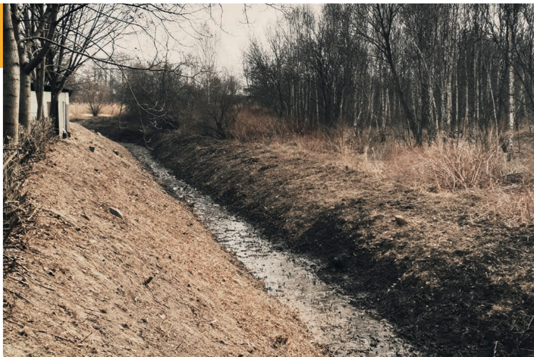
Czyszczenie koryta „Potoku Zagórskiego” fragment I i II.
