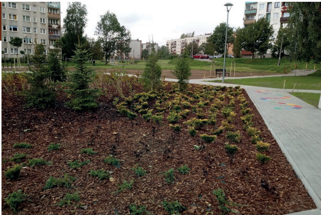
Budowa mini parku zielona strefa odpoczynku przy ul. BMC.
