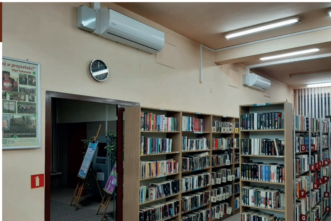
Klimatyzacja w bibliotece – zakup i montaż filia nr 15 – MEC.
