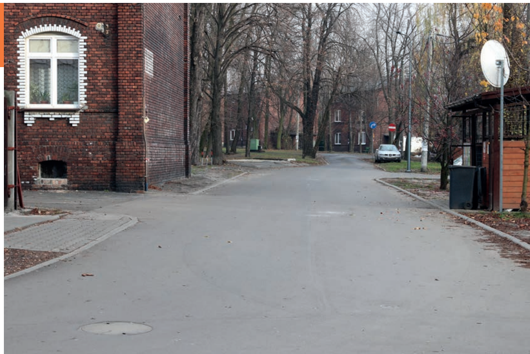
Remont drogi asfaltowej ul. Maliny.
