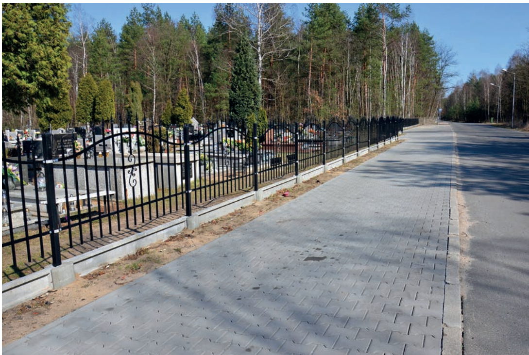
Budowa parkingu przy ul. Stare Maczki.
