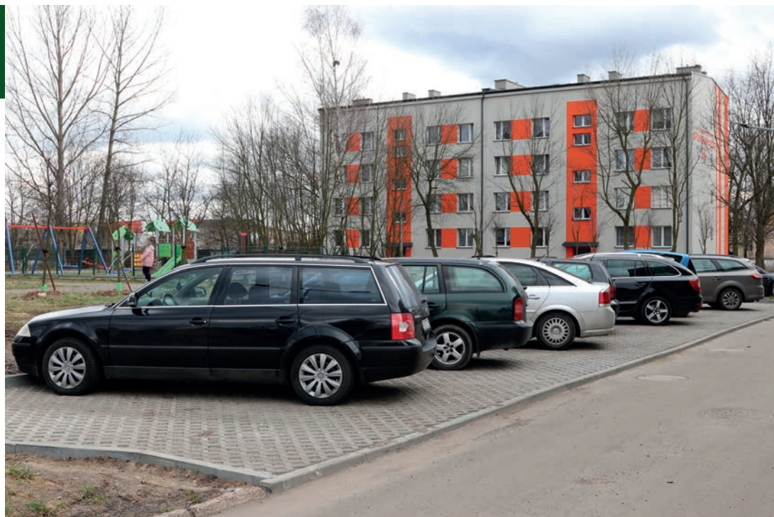
Osiedle Broniewskiego – budowa miejsc parkingowych.
