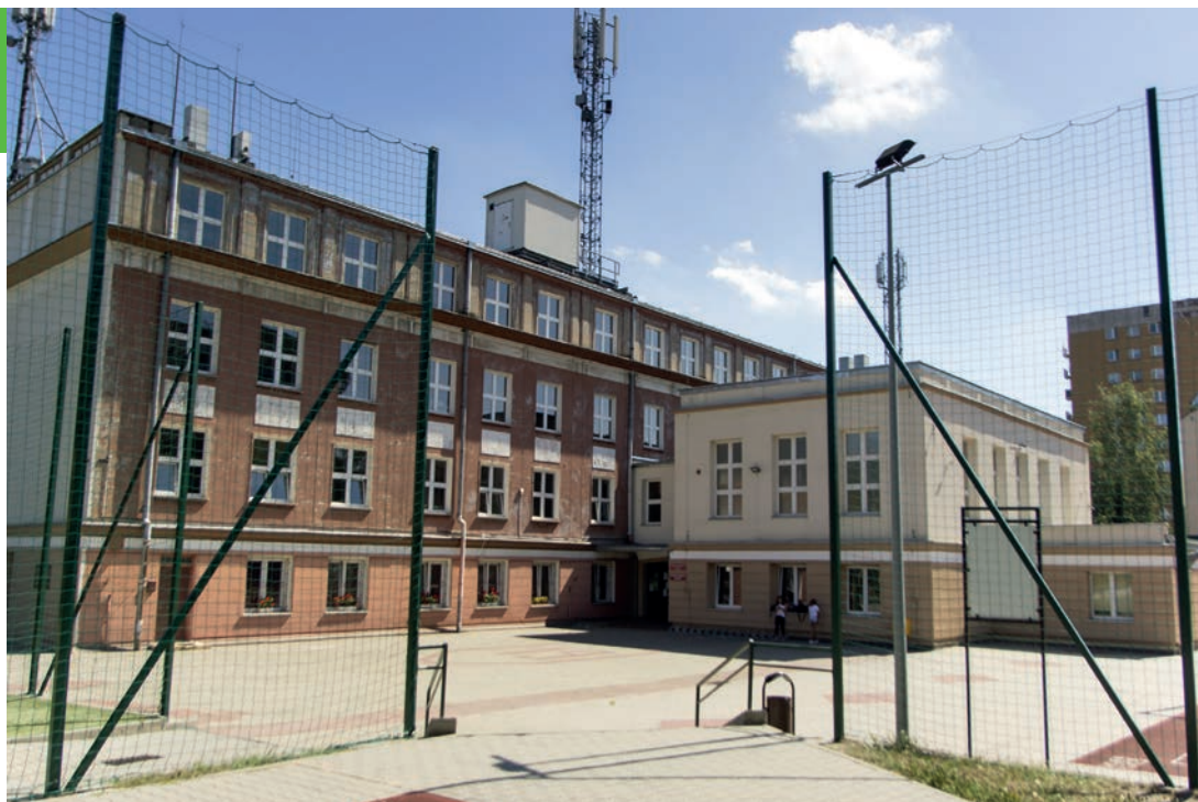
Termomodernizacja sali gimnastycznej przy SP nr 19, ul. Składowa.
