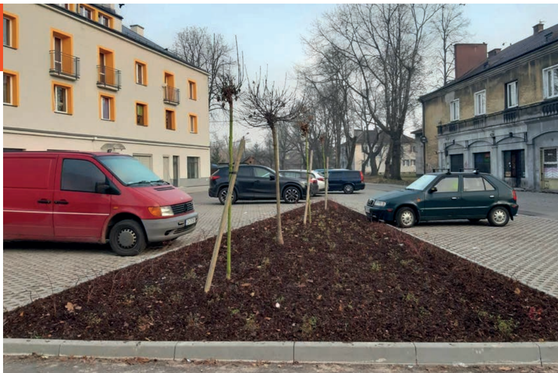
Budowa parkingu przy ul. Wrzosowej.
