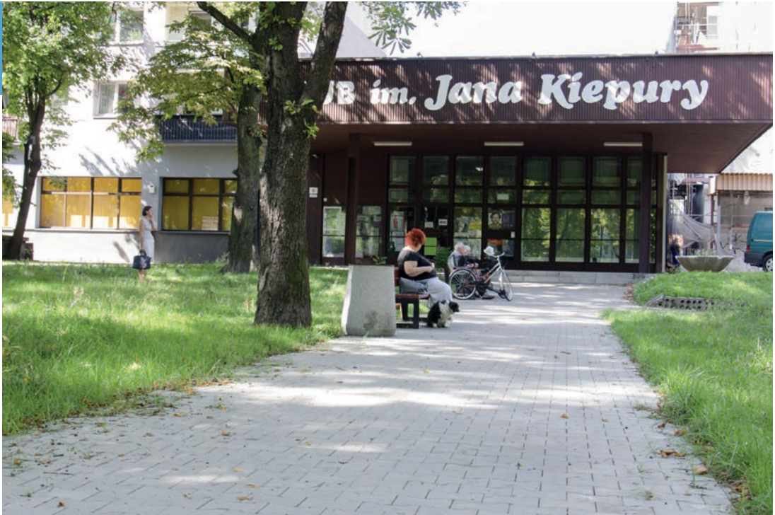
Rewitalizacja zieleni i infrastruktury pieszej, ul. Będzińska.
