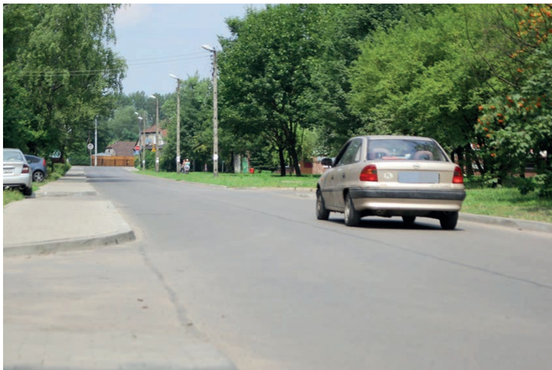
Generalny remont nawierzchni pomiędzy osiedlem Wagowa I, a Wagowa II.
