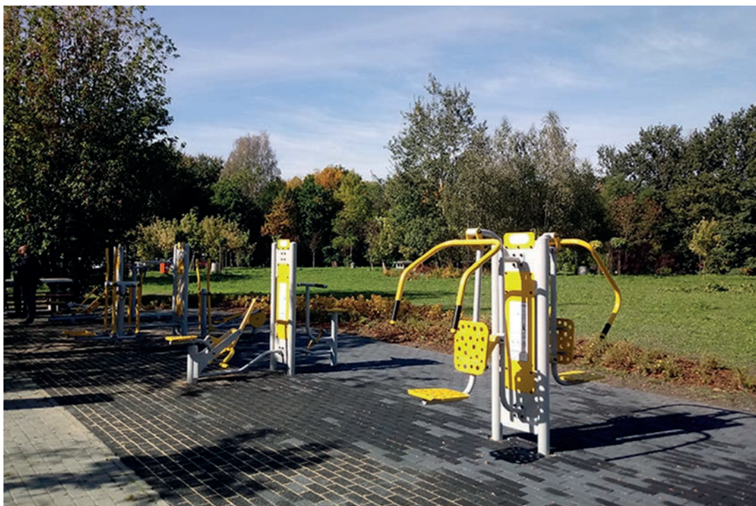
Montaż 8 stanowiskowej siłowni, ul. Dybowskiego.
