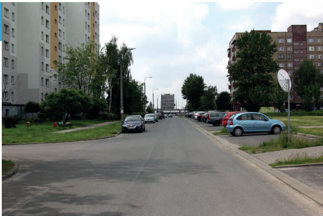
Remont ul. 11 Listopada.
