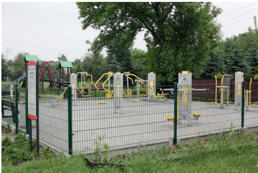
Budowa siłowni zewnętrznej, ul. Zawodzie.
