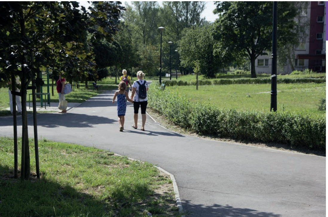
Remont alejek, Plac Braci Kozuchów.
