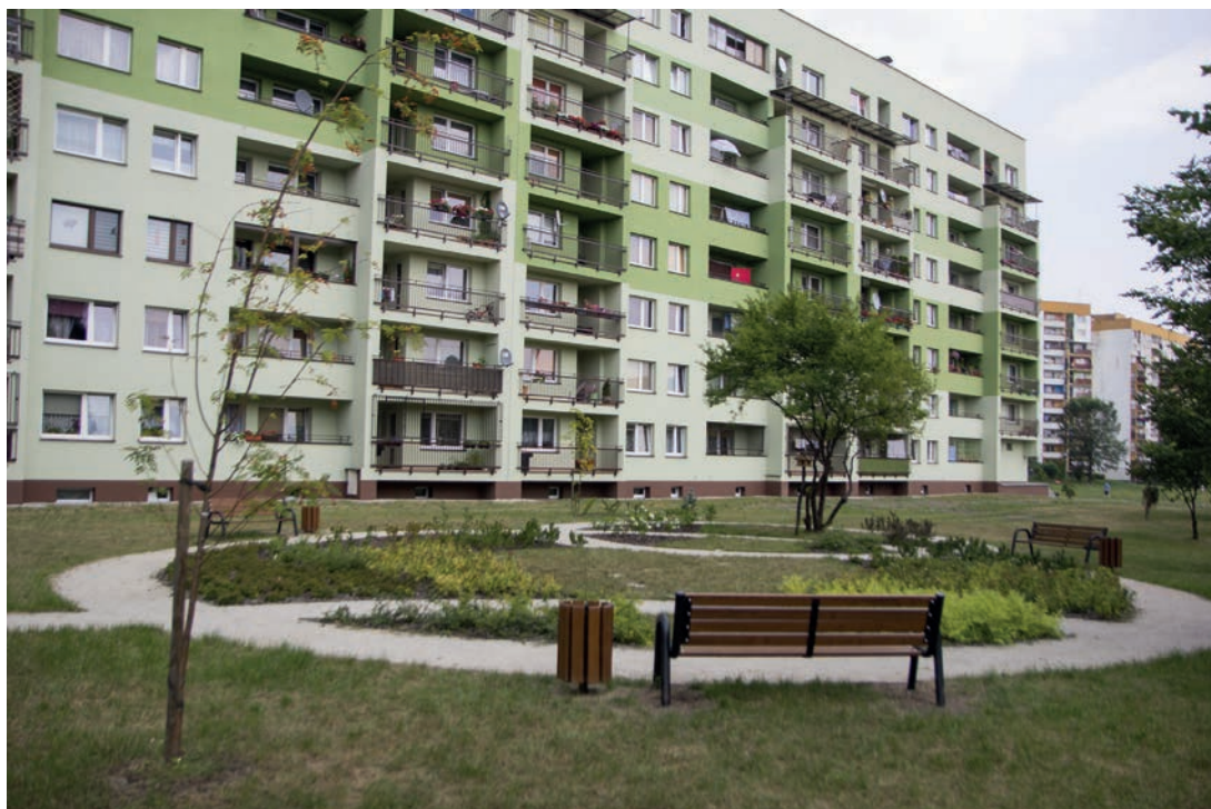
Budowa skweru wypoczynkowego, ul. Białostocka.
