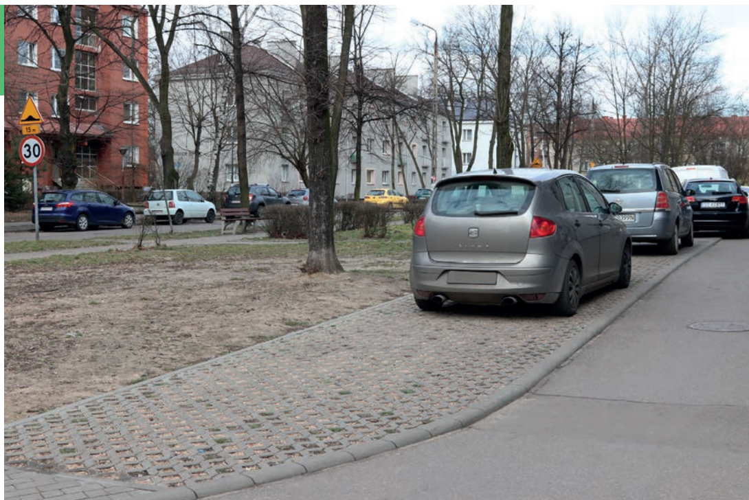
Budowa zatoczek parkingowych na osiedlu Juliusz.
