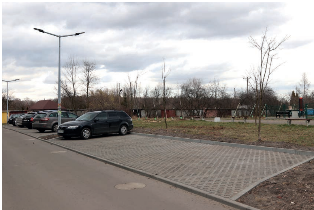
Wykonanie chodnika z kostki na ul. Wagowej 64-70 oraz miejsca parkingowe na ul. Wagowej 60-70.
