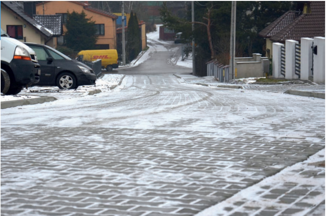
Budowa drogi na części ul. Jabłoniowej.
