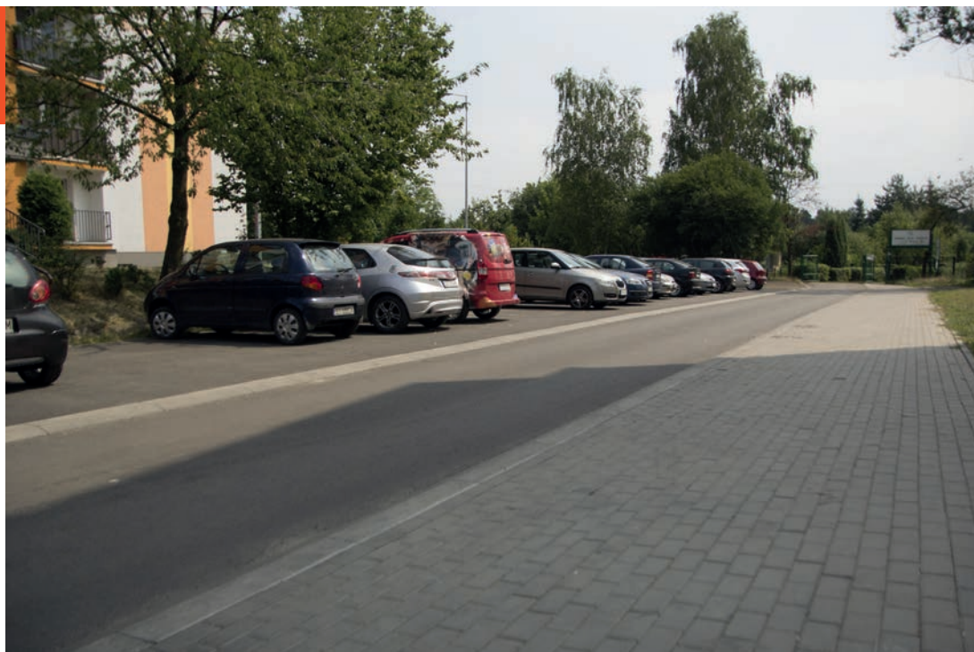
Remont fragmentu ul. Kalinowej.
