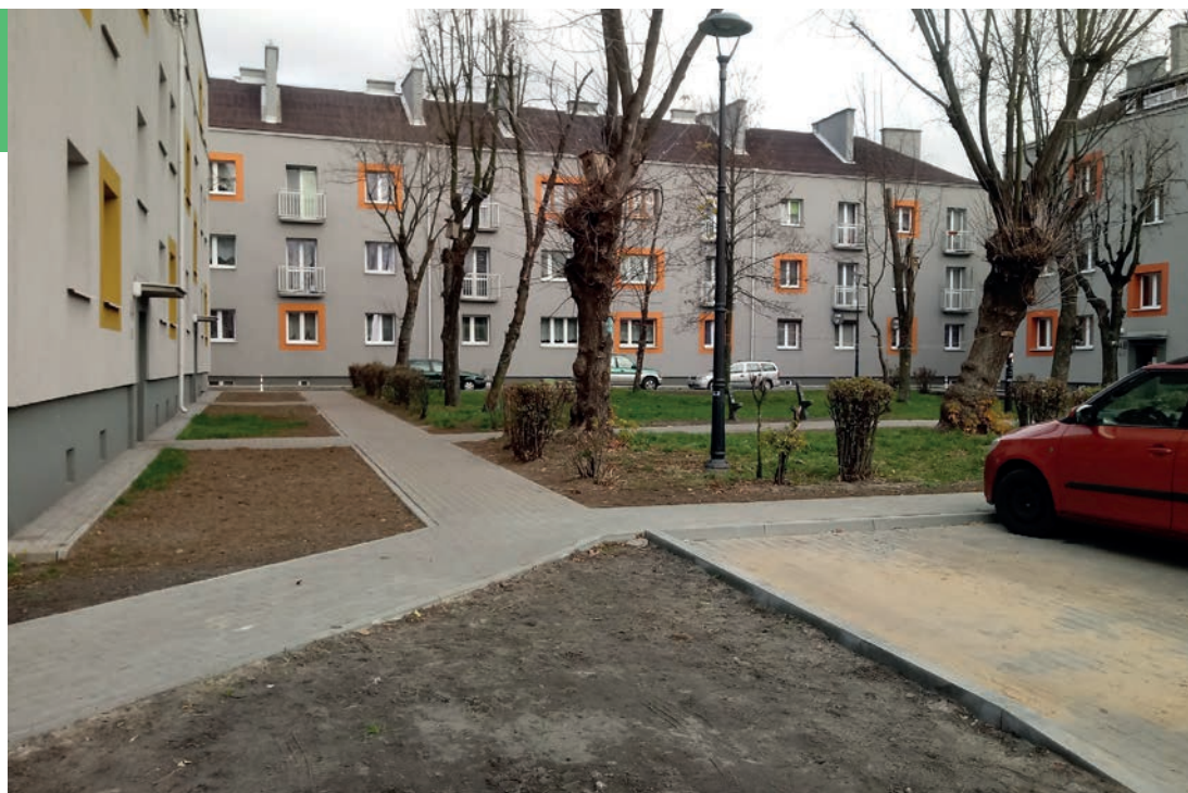
Budowa chodnika na ul. Czołgistów.
