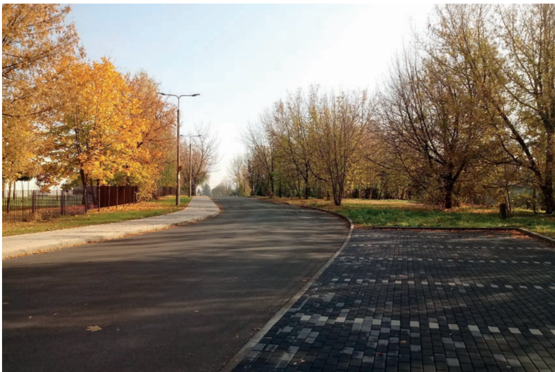
Remont drogi i chodnika do szkoły i kościoła przy ul. Gwiazdnej.
