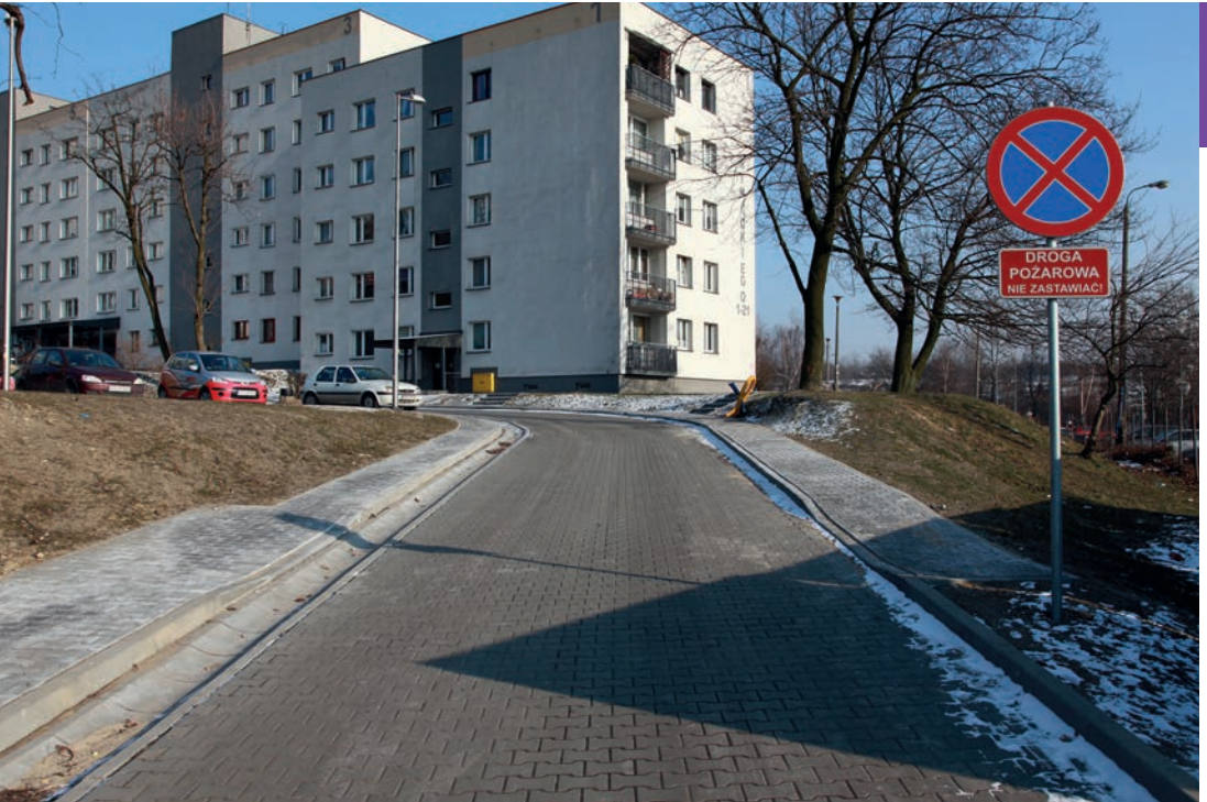
Wewnętrzna, osiedlowa droga pożarowa wraz z placem manewrowym przy ul. Wybickiego z dojazdem do nowo powstałego placu zabaw.
