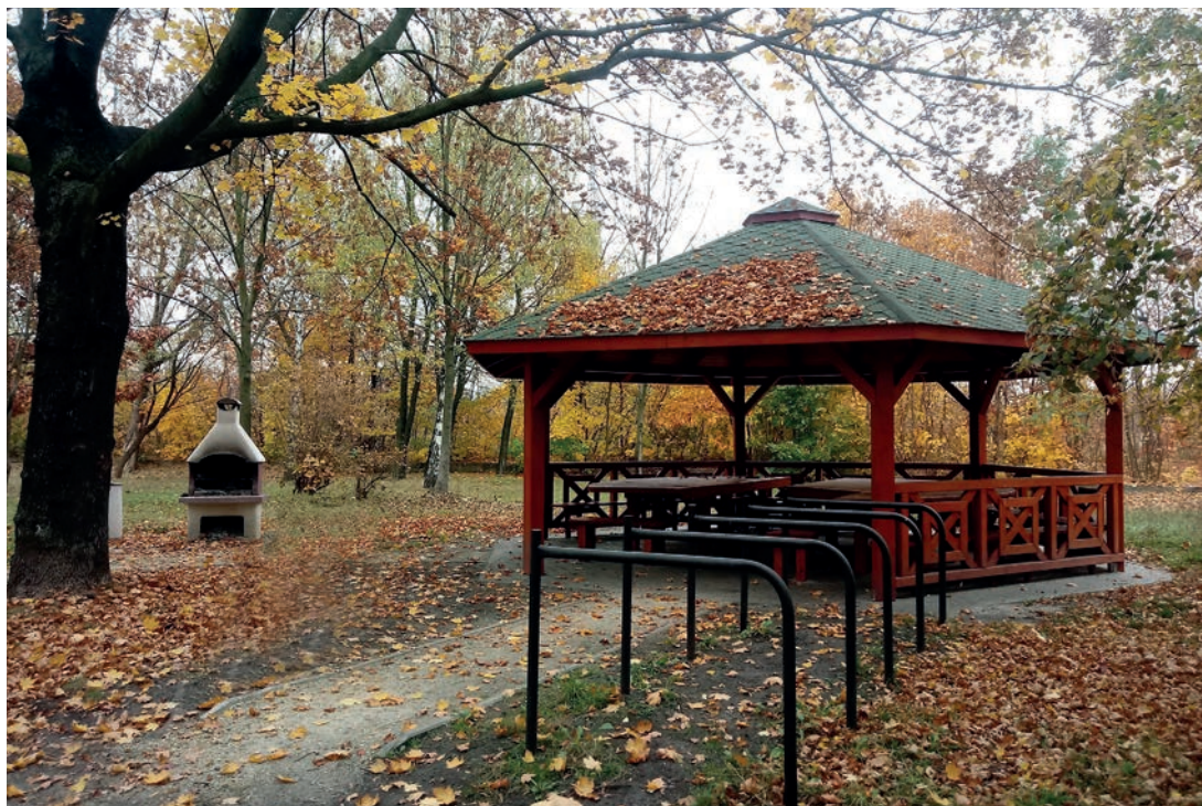
Ośrodek rekreacyjny „Wygoda”. Etap II – budowa altany biesiadnej ze stanowiskiem do grillowania, ul. Powstańców.
