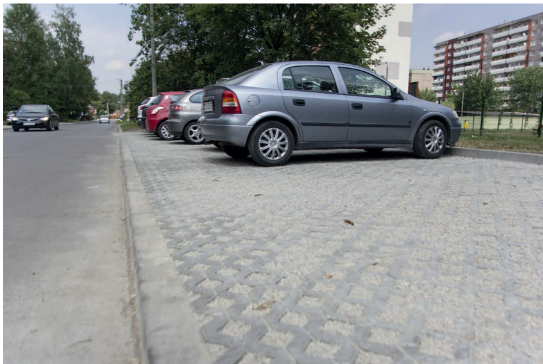
Budowa parkingu dla mieszkańców Starej Wagowej.
