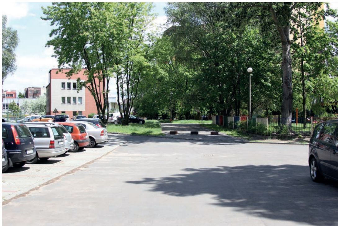
Remont parkingu w rejonie, ul. Ordonówny i ul. Kilińskiego – etap II.
