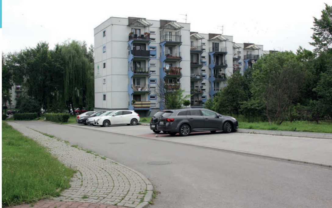
Budowa miejsc parkingowych, remont chodnika, ul. Żelazna.
