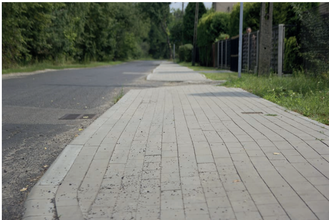
Remont chodnika, ul. Leśna.
