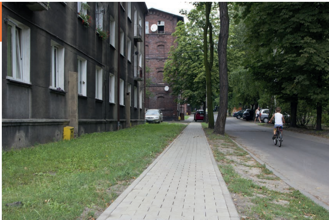
Remont chodnika, ul. Maliny / Niwecka.
