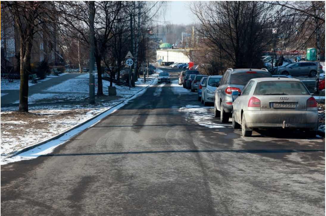
Remont drogi asfaltowej i budowa chodnika z kostki, ul. Długosza od 19 do 43.
