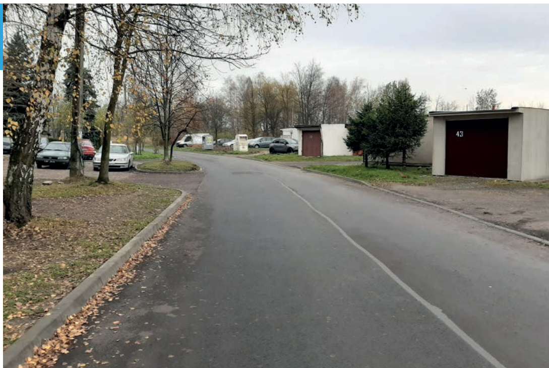
Wymiana nawierzchni drogi ul. Zapolskiej.
